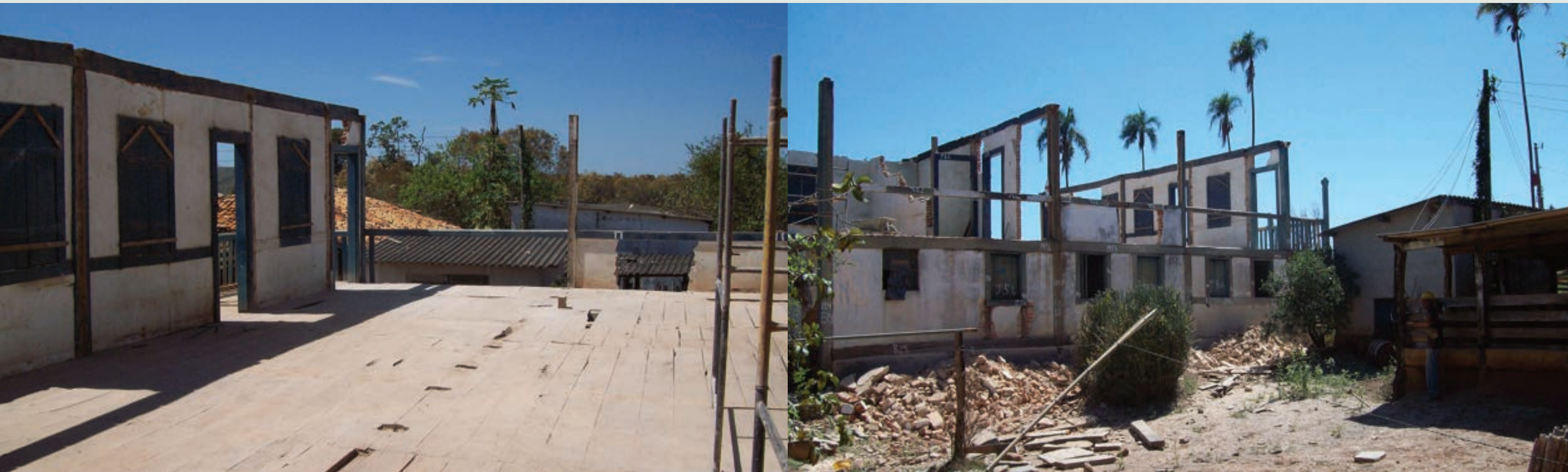
Desmonte da fazendo original em setembro de 2009
