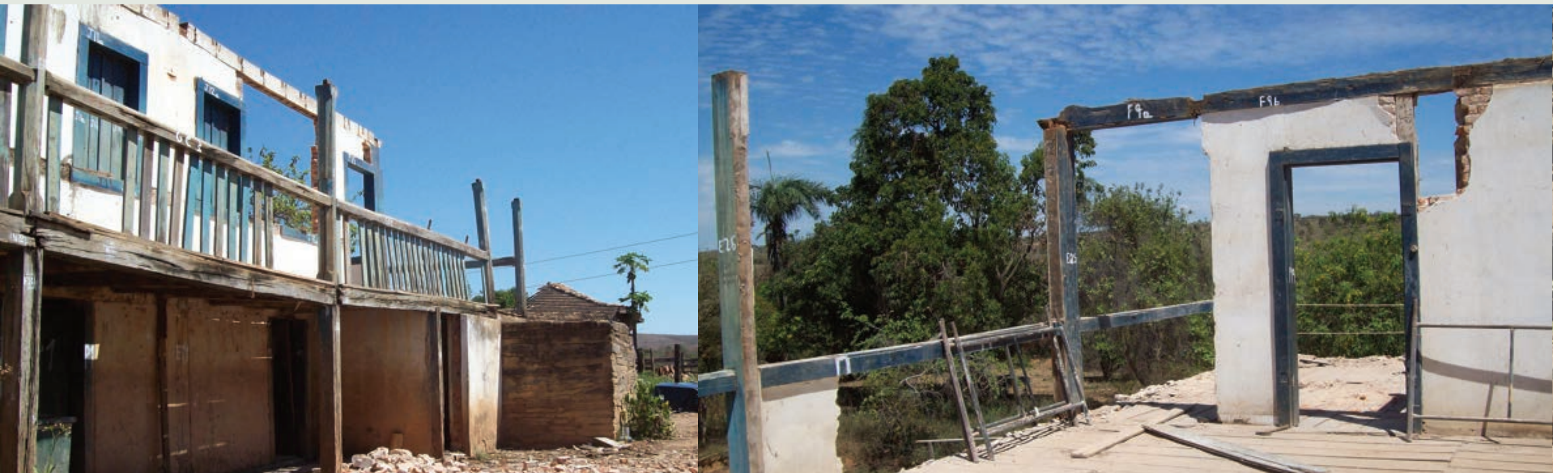
Desmonte da fazenda original em setembro de 2009
