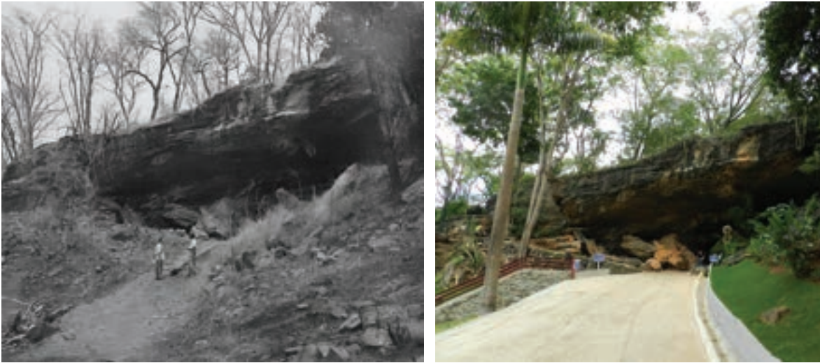
Obras para adequação do acesso a gruta. Fonte: IBGE, s/d. Entrada da gruta em 2013. Foto Adriano Carvalho.
